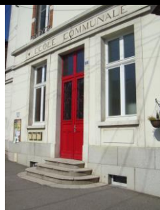
réhabilitation école communale (2011) et périscolaire (2015)
