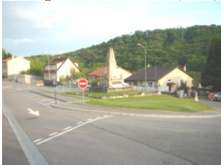
Aménagement carrefour Rue de Gorze (2005)
