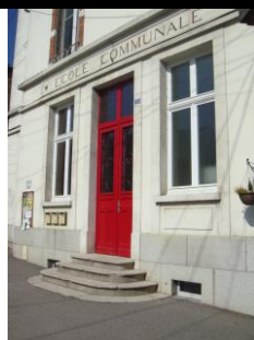
réhabilitation école communale (2011) et périscolaire (2015)
